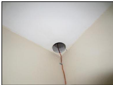
Photo N° 1145 AMIANTE CIMENT - -PALIERS RDC à +4 Plafonds Fourreau
